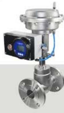
卧式气动定位器, 安装到各种气动阀门
